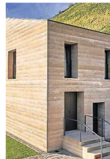
Die Remise, die als schlichtschöner Kubus errichtet wurde.
